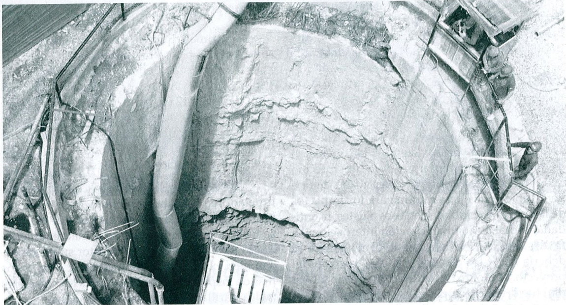
Túnel interceptor de aguas negras, norte de Bogotá
