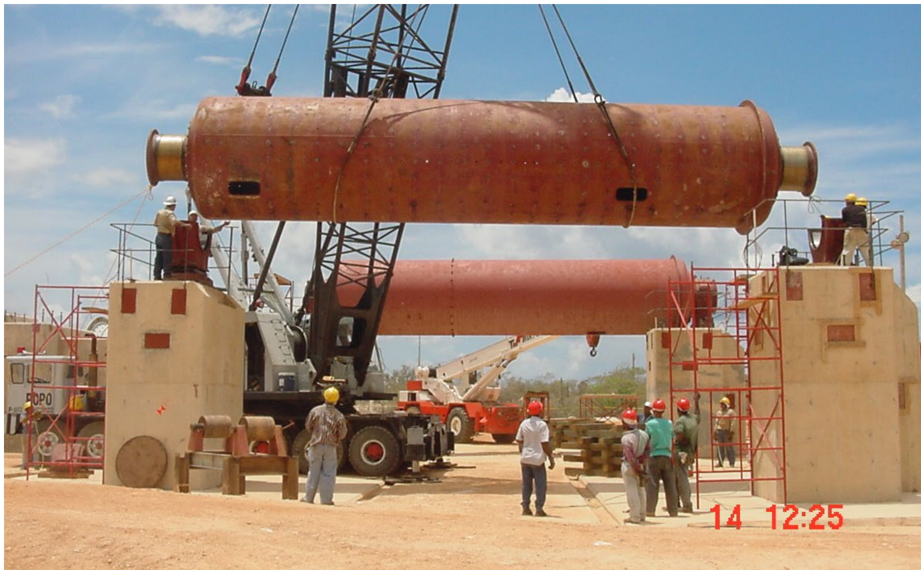
Fotografía ZJ Ingenieros Estructurales SAS
