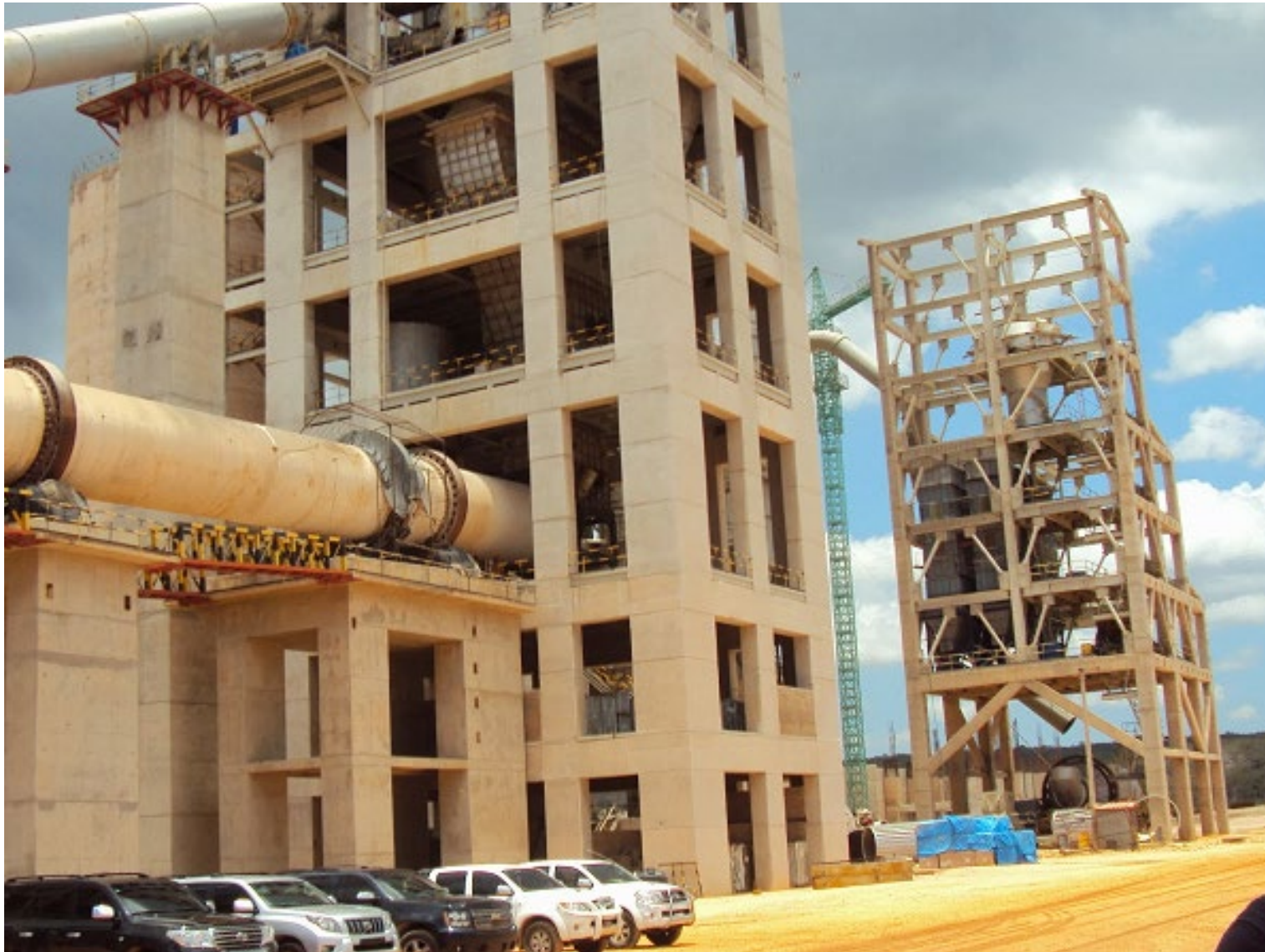
Fotografía ZJ Ingenieros Estructurales SAS
