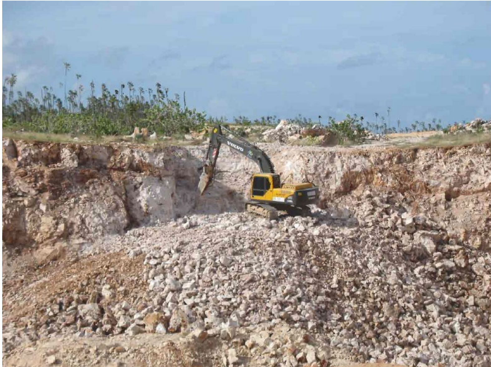
Fotografía ZJ Ingenieros Estructurales SAS
